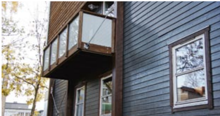
Ekteparet har bodd i dette nabolaget i 22 år, og hadde et sterkt ønske om å integrere den gamle boligen i det nye leilighetskomplekset. Det ble gjort, og i dag er alt det opprinnelige malt i grått. Vindstag ble plassert på den opprinnelige delen, og utgjør en viktig del av byggets uttrykk.
