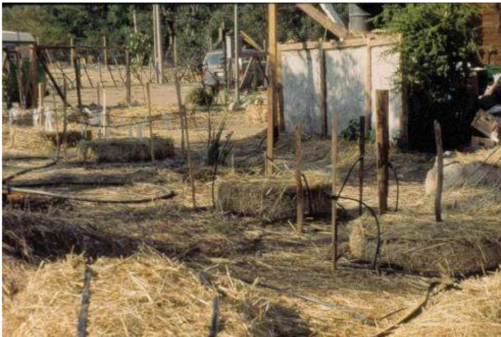
Construcción de camas circulares Ecovilla Camila, Olmue ,Chile , 1995
